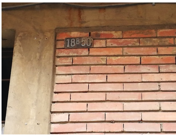
Foto No. 4 Fachada del establecimiento
