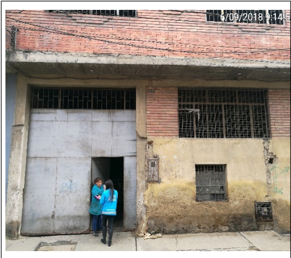
Foto No. 1 Fachada del establecimiento
